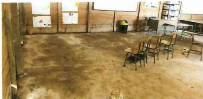
REPARACION DE PISO DEL EDIFICIO ESCOLAR
