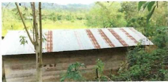
CAMBIO DEL CUBIERTO DE LAMINAS DEL EDIFICIO EDUCATIVO POR EL DETERIORO.
