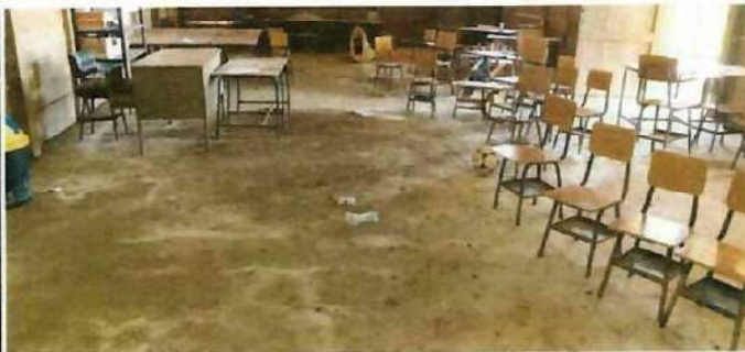
MANTENIMIENTO DEL PISO DEL EDIFICIO ESCOLAR
