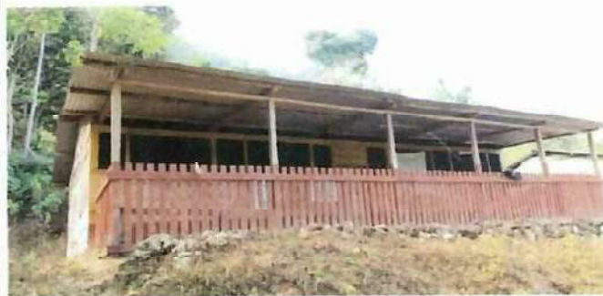
CAMBIO DE VIGAS DE MADERA POR COSTANERAS DE METAL
